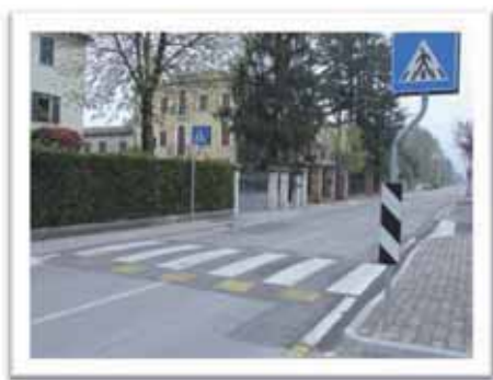
I dissuasori di traffico realizzati per garantire la sicurezza di via S. Rocco
