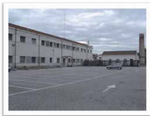
L'edificio che ospiterà l'archivio comunale
