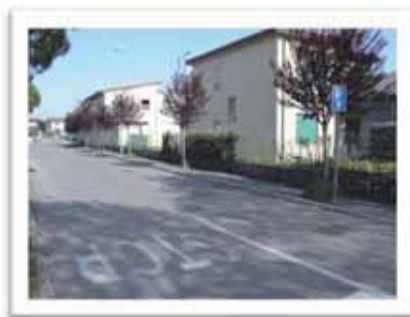
Via Cima da Conegliano rimessa a nuovo
