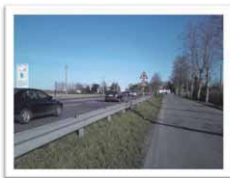
Un tratto della TV Mare all'altezza di Vallio
