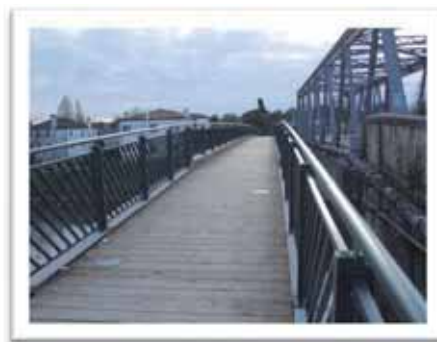
Dettaglio della passerella
