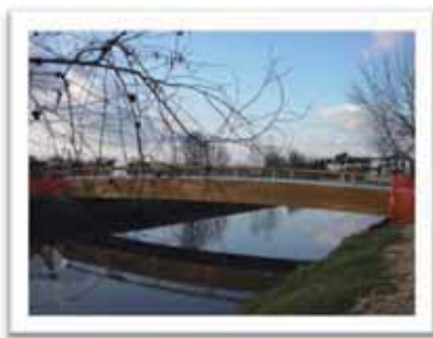
La nuova passerella sul fiume Musestre
