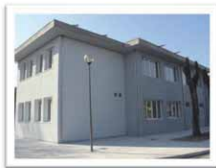
La facciata nord restaurata delle ex scuole elementari
